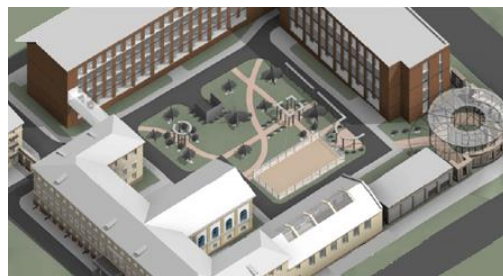
Реставрация главного корпуса, Пермский авиационный техникум им. А.Д. Швецова
