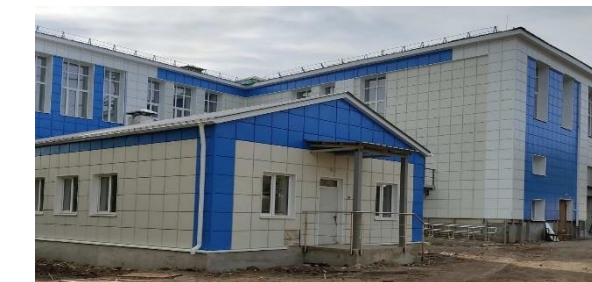
Реконструкция мастерских, Лысьвенский политехнический колледж
