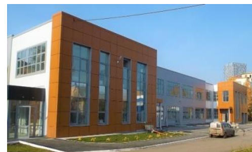
Учебно-производственные мастерские, Пермский строительный колледж
