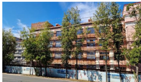
Реставрация корпуса политехнического колледжа им. Н.Г. Славянова, 1000 мест
